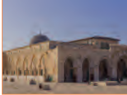
المسجد القبلي جزء من المسجد الأقصى / القدس
