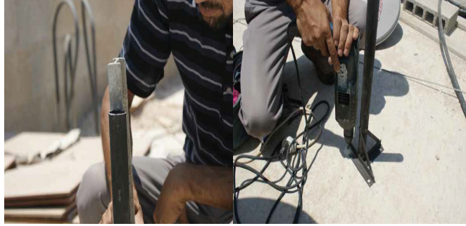
الشكل (11): تثبيت قاعدة الطبق بشكل عمودي على الأرض
