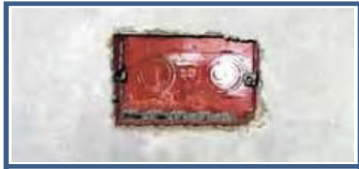
الشكل (3) : تثبيت العلب الكهربائية داخل الجدران
