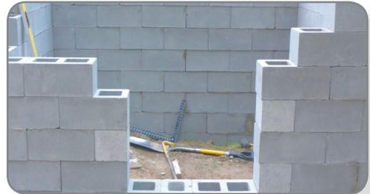
12- التشريك (الربط): ترتيب خاص لبناء الطوب يضمن عدم انطباق الحلول الرأسية للمداميك المتتالية بعضها على بعض، كما في الشكل (33).
