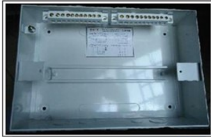
تثبيت جسر الإيرث وجسر النيوترال وجسر حامل القواطع
