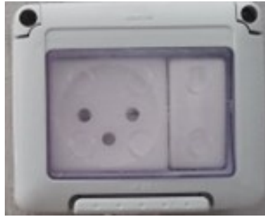
إبريز مطري ورمزه الكهربائي
