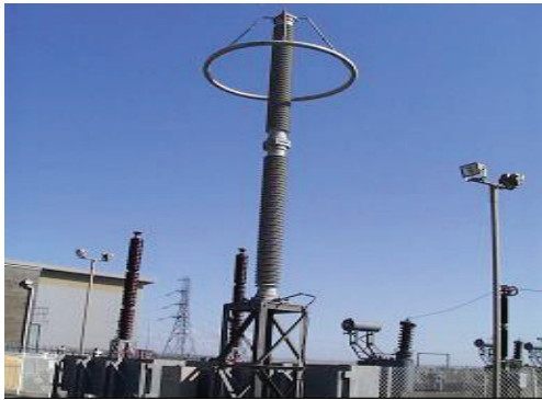
شكل (3): حارفة الصواعق في محطات توليد الطاقة
