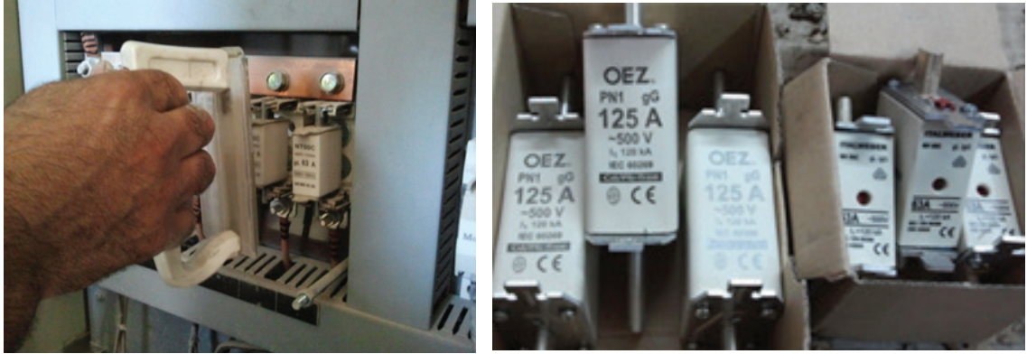
شكل (2): مصهر سكيني والطريقة الآمنة لاستبدال التالف داخل لوحة توزيع
