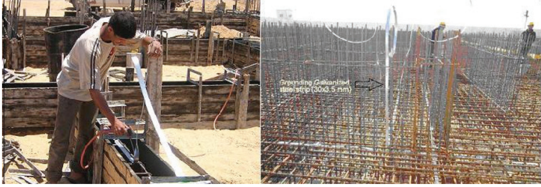
شكل (6): طريقة لحام شبكة حديد الأساسات باستخدام شريط مجلفن من الحديد
