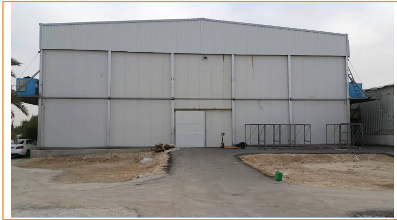
الشكل (1) غرفة تبريد كبيرة
