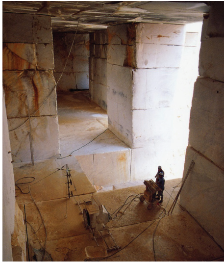
محجر رخام تحت سطح الأرض، ويلاحظ الأعمدة المتروكة؛ لتدعيم استقراره
