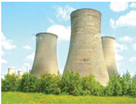
**نشاط ١ :** الشكل المجاور يمثل صورة لأبراج تبريد تستخدم في المفاعلات النووية. وهذه الأبراج عادة تتخذ هذا الشكل لزيادة سرعة البخار عند منطقة الوسط ومن ثم تتسع الفتحة عند الطرف العلوي لتقليل سرعة خروج البخار من الفوهه. هل يمكنك وصف الحواف الجانبية لهذه الأبراج؟ أرسم شكلاً تقربياً لهذه الحواف.
